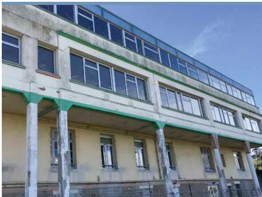
Le parc d'innovation Blue Valley dans le site du Laber, en cours de rénovation © J.-M. M.
