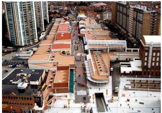
Photographie n°13 : Une « rue » traditionnelle construite de toutes pièces qui s'apparente à un décor de théâtre ou de film (SEM Ville Renouvelée).
